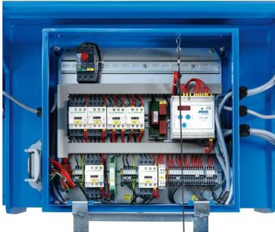
*ABUS Elektrik 3 mit Schützsteuerung*
